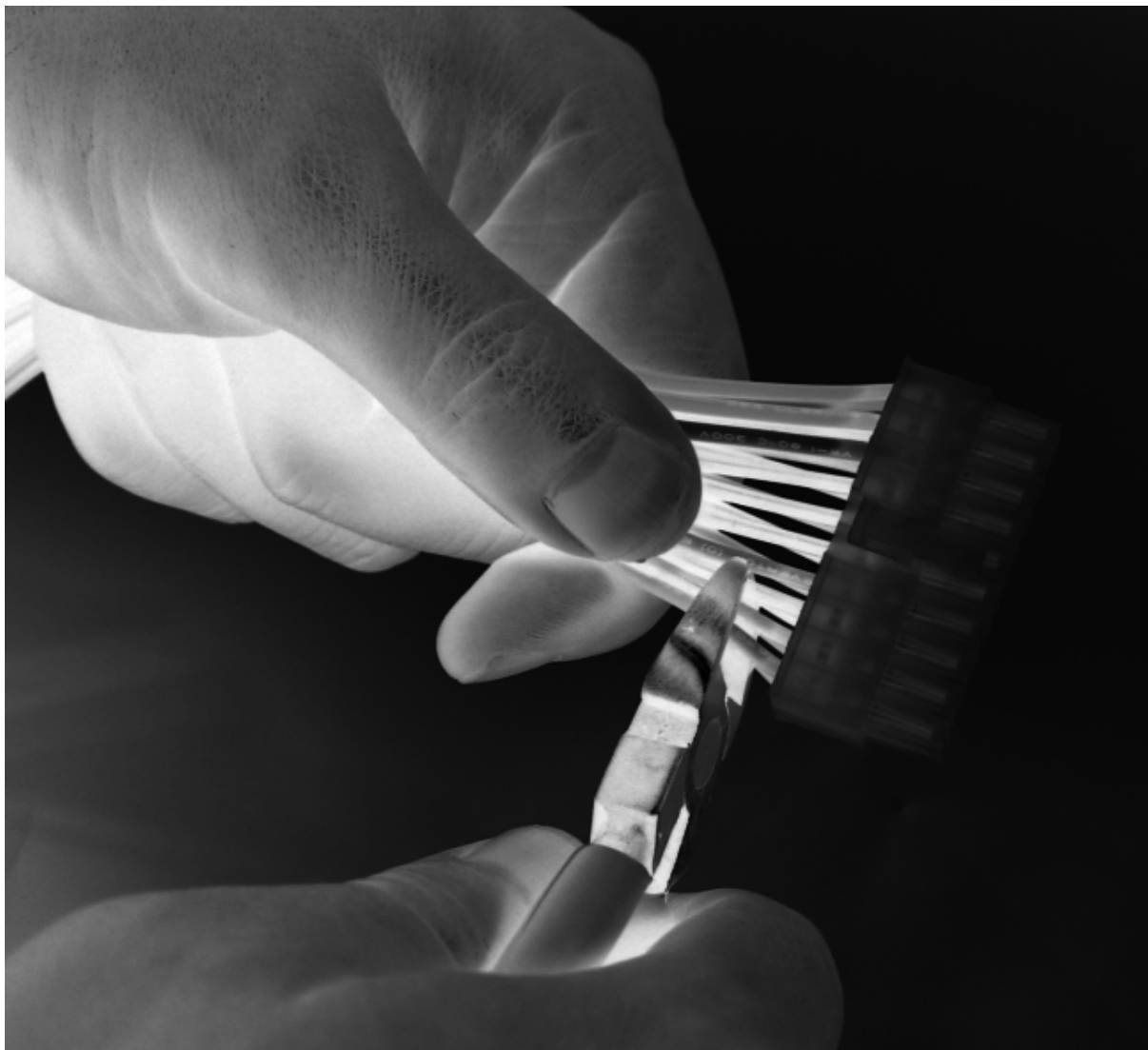
Рисунок 5-1. Отрежьте разъем от кабеля АТХ-блока питания.
